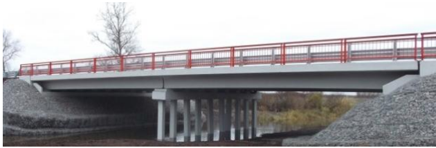
Рис. 1. Общий вид двухпролетного железобетонного моста
