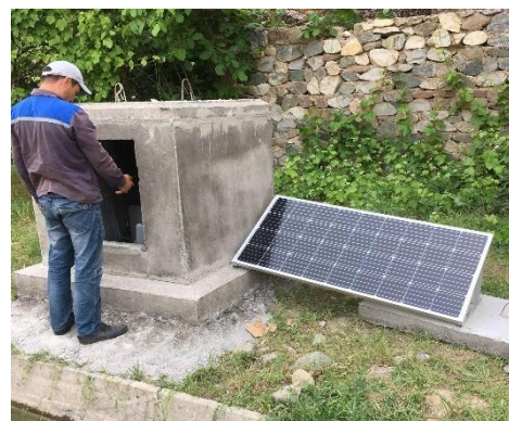
Рис. 5. Установленное оборудование на грунте.
